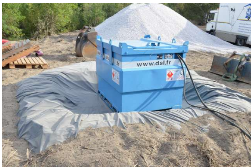
☞ Photographie 13 : Mise en place d'une aire étanche autour d'un groupe électrogène
