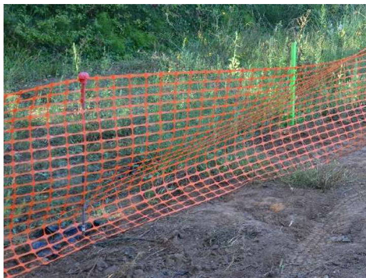
☞ Photographie 7 : Dispositif de limitation des emprises des travaux
