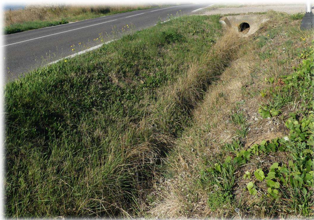
☞ Photographie 3 : Le fossé busé
