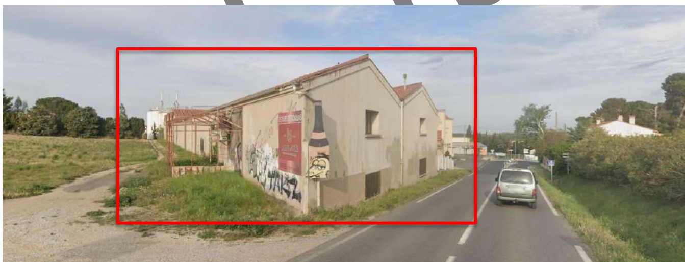
Vue depuis la RD612 en provenance de Thuir
