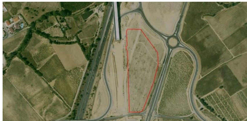
Figure 12 : vues aériennes du site dégradée, source google Earth 2006
