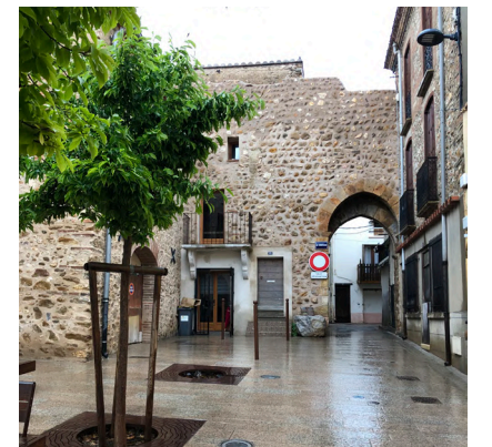
Maçonnerie rustique en moellons
