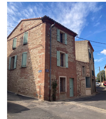
Murs de moellons de pierres schisteuses, chaîne d'angle en brique
