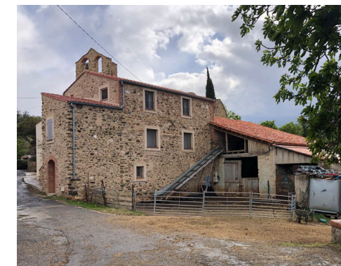
Murs en moellons et toiture en tuiles canal
