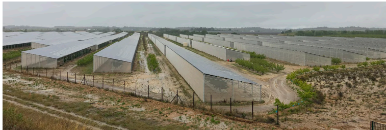
Parc agrivoltaïque à Trouillas :
