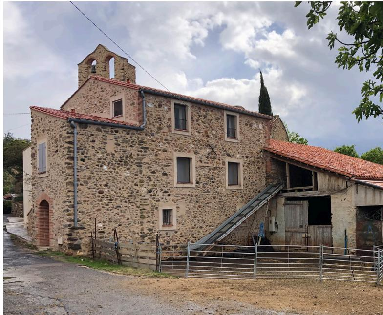
Murs en moellons et toiture en tuiles canal (Oms)
