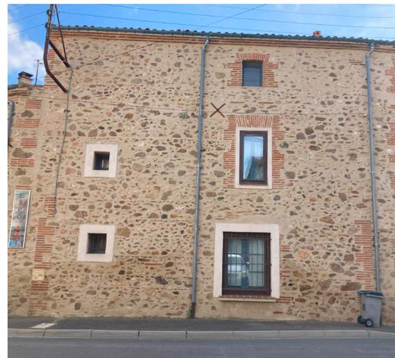
Murs de moellons de pierres schisteuses, chaîne d'angle en brique (Fourques)
