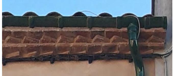
Les **chéneaux**, les **descentes** et les **gouttières** en zinc, en cuivre ou en terre cuite vernissée ont leur importance dans la protection de la façade car ils contribuent à éloigner l'eau de la façade. La corniche en terre cuite, recouverte par les tuiles, est appelée tortugada (prononcer tour-tougade).
