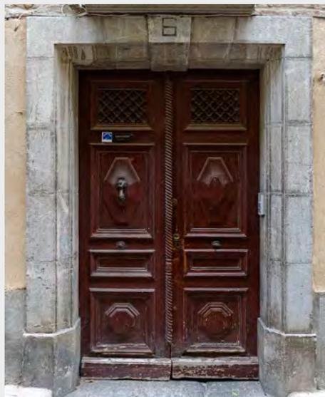
Encadrement en pierres de taille moulurées. Linteau composite en plate-bande avec clef saillante. La menuiserie du 19<sup>e</sup> siècle à panneaux sculptés et fausse pilette torsadée est typique de la région.
