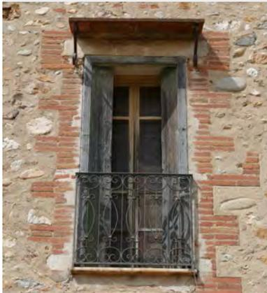
Fenêtre à deux vantaux. Encadrement en bois. Contrevents traditionnels en bois. Contrevents à brisures (4 vantaux se pliant dans le sens de la hauteur).
