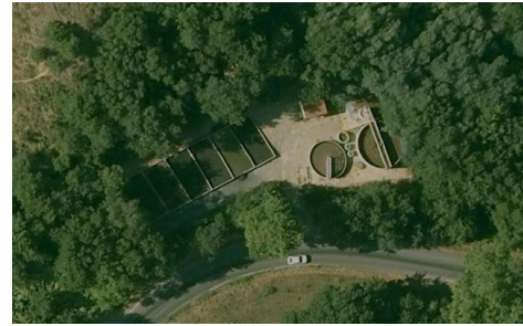
Station d'épuration de Brouilla
