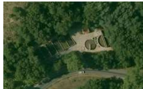
Station d'épuration de Brouilla
