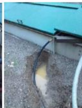
Enfouissement des conduites de récupération des eaux filtrées
