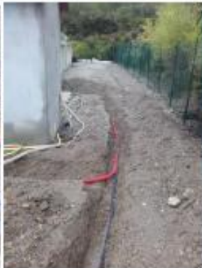
Enfouissement des conduites de récupération des eaux filtrées
