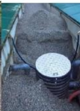
Enfouissement des conduites de récupération des eaux filtrées
