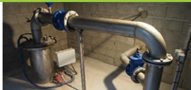
Dans le cadre de l'arrêté préfectoral d'autorisation d'exploitation du forage F1bis situé à FOURQUES, les travaux de protection du forage contre les inondations et de sécurisation de la ressource ont été réalisés dans le courant du mois de juin 2017. Ainsi, un bâti étanche a été construit autour de la tête de forage, une pompe de secours a été approvisionnée et le fonctionnement du groupe électrogène a été fiabilisé. Le forage de FOURQUES participe à l'alimentation en eau potable de 14 communes.
