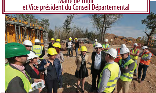
Visite du chantier de la STEP intercommunale de Thuir
