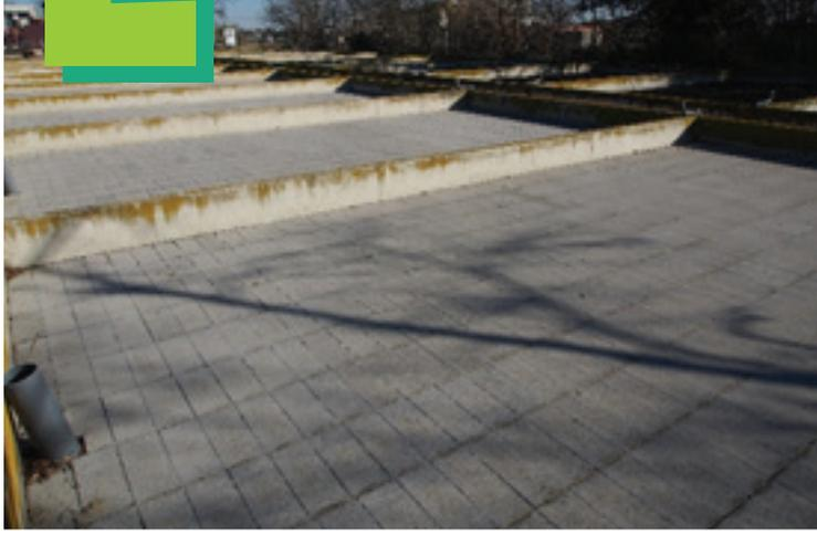
Les lits de séchage de l'ensemble des stations d'épuration, exceptés ceux de Banyuls dels Aspres, sont en cours de réhabilitation par mise en œuvre de hourdis.
