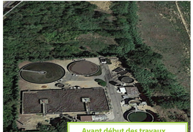
Avant début des travaux...
